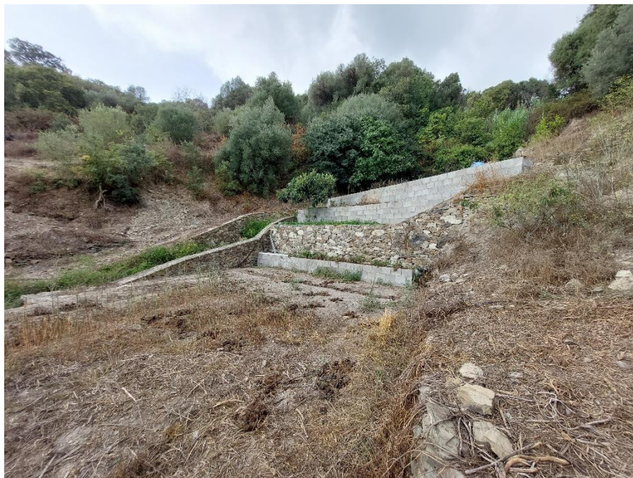
Figura 9 - Vista da valle verso monte della "briglia" esistente sul vecchio alveo del rio Funtana Manna, attualmente in disuso a seguito della canalizzazione del rio
