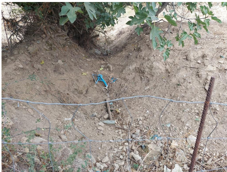
Figura 4 - Controvista delle condizioni del versante e dell'alveo inciso del rio Funatana 'e Sì a monte dell'imbocco nel manufatto in cls: si noti l'assenza di rivestimenti e soluzioni di contenimento del materiale vegetale o solido
