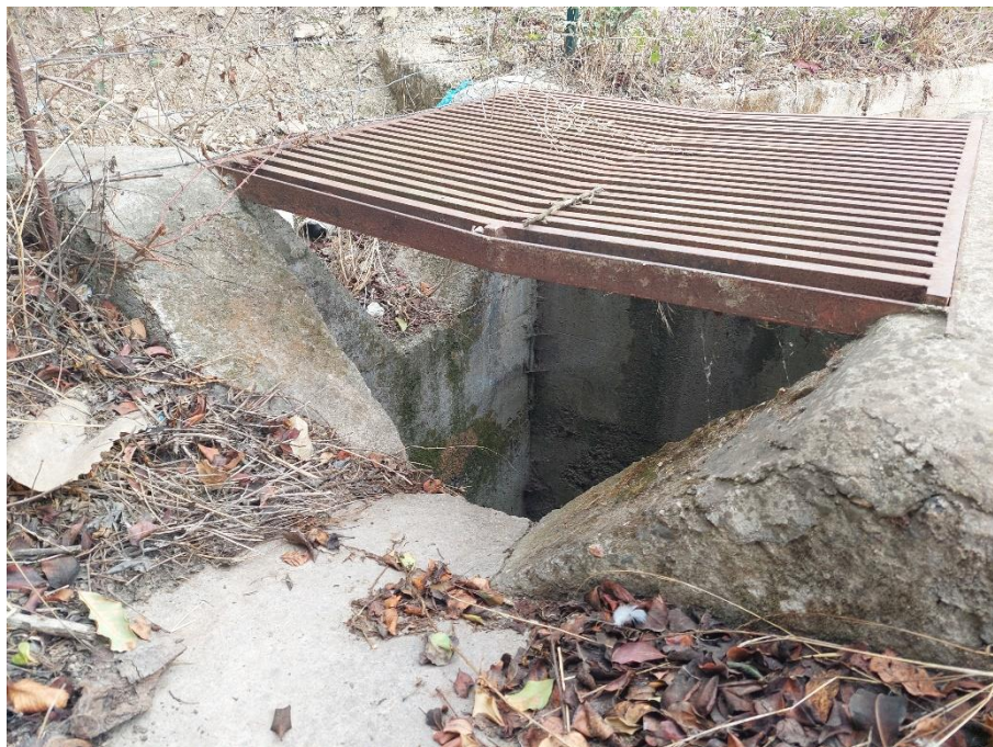
Figura 3 - Vista di dettaglio (da monte verso valle) del manufatto in cls esistente a valle dell'impluvio per l'imbocco ed il collettamento delle portate verso la parte tombata del rio Funtana 'e Sì
